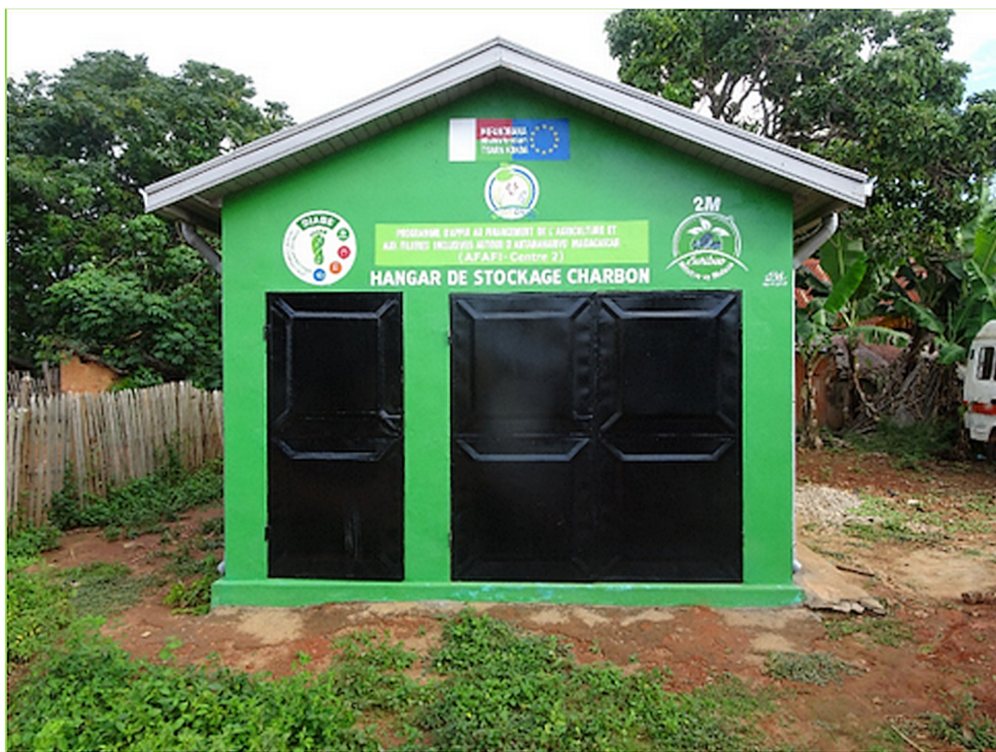
Hangar de stockage du charbon de bois « 2M » issus de Techniques Améliorées de Carbonisation à Ankazobe / Photo : Mike Temmerman.
